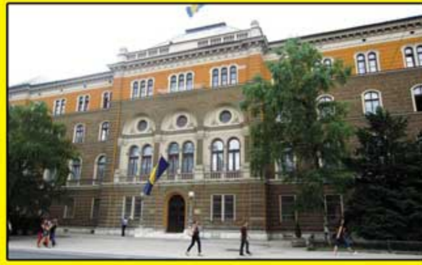
2. ZGRADA PREDSEDNIŠTVA BOSNE I HERCEGOVINE
